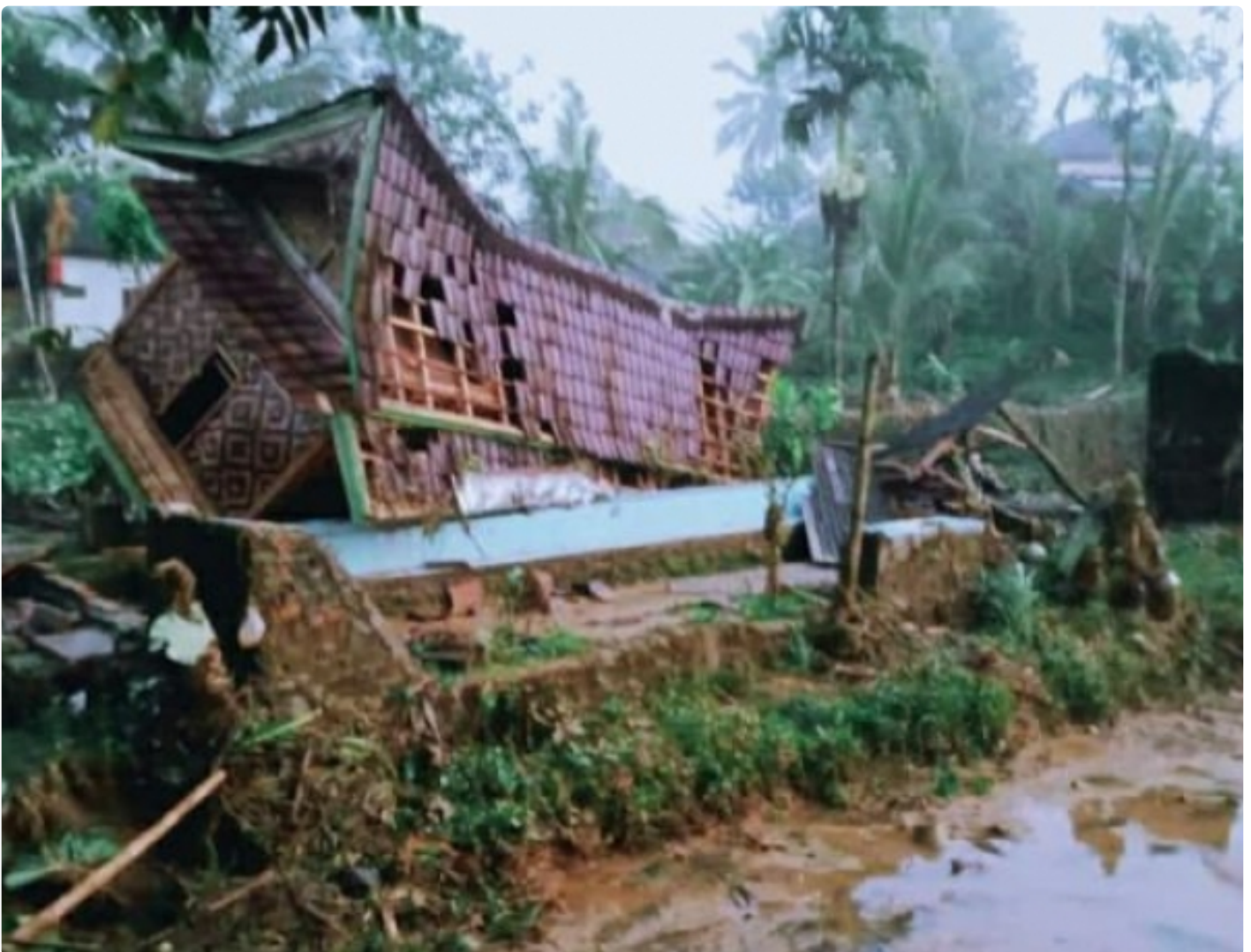
Hujan deras rendam dan rusakan rumah warga Cigemblong Lebak Banten
